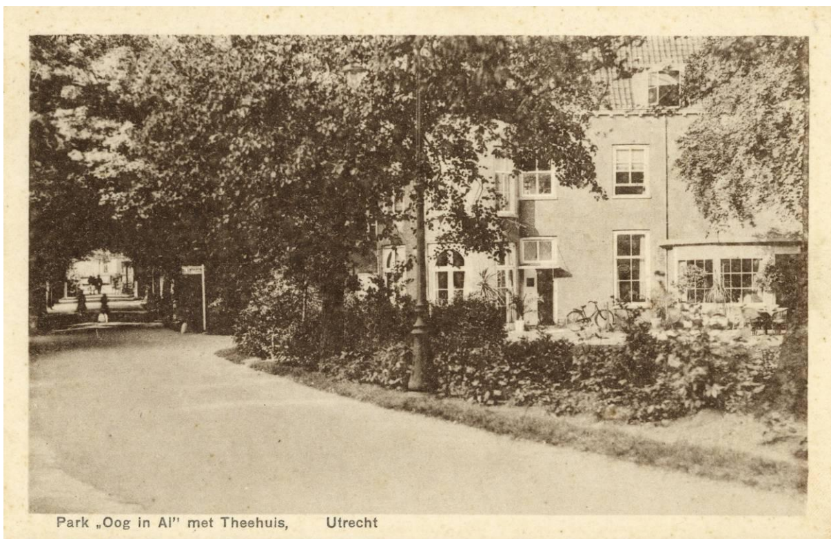
Zicht op het theehuis vanaf het hoofdpad. Links zicht door de bruine beukenlaan richting de entree met brug vanaf de Kanaalweg. Grasstrook aan weerszijden van het pad. Bij het huis zijn enkele kuipplanten opgesteld (palmen en varens). Prentbriefkaart uit ± 1925. (Bron: HUA, cat. nr. 3550.)
